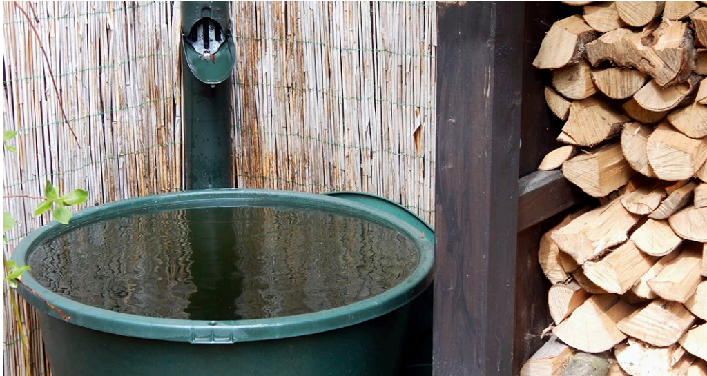
Abbildung 6: Die Bewässerung des Gartens mit Regenwasser verringert die Entnahme aus der Leitung und begünstigt die Versickerung vor Ort statt das Wasser in die Kanalisation zu leiten. Das spart Leitungswasser und hat durch die Verdunstung einen kühlenden Effekt. Daher ist es als Anforderung im Ökologischen Kriterienkatalog München unter Punkt 4.6 festgeschrieben.
