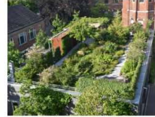
→ Abb. 19: Intensives Gründach auf einem Verwaltungsgebäude
