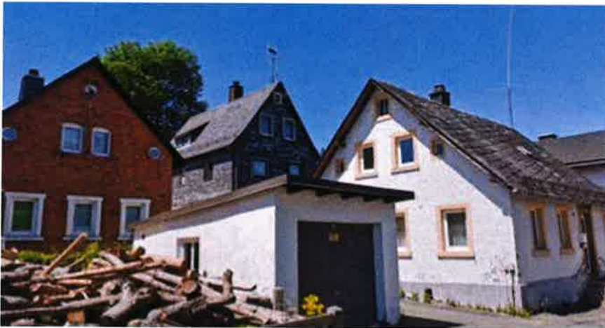
neuzeitliches Nebengebäude mit Pulldach
