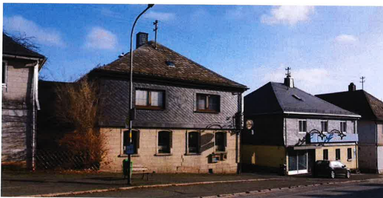
Herrschaftliche landwirtschaftliche Anwesen, Sockel in Sandstein, Obergeschosse verschiefert, im Bereich der Lobensteinerstraße
