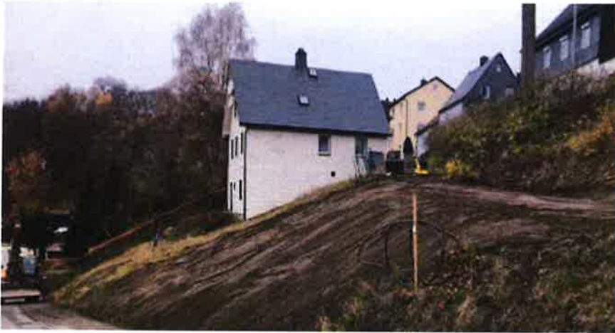
Begrünung Hangkante nach Abbruch Gebäude
