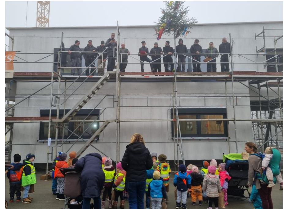
Neubau von Werkstatt und Ausstellungsraum der Fa. Adlerhaus
